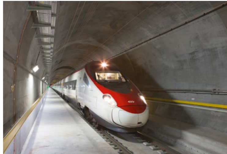
03 Zug im Gotthard- Basistunnel
